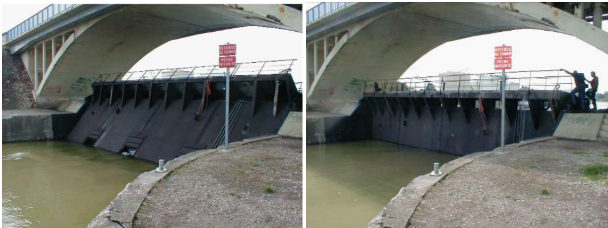
Figure 3: A gauche: porte flottante et mise en place sur ses tourillons / A droite: porte ballastée qui ferme la passe
