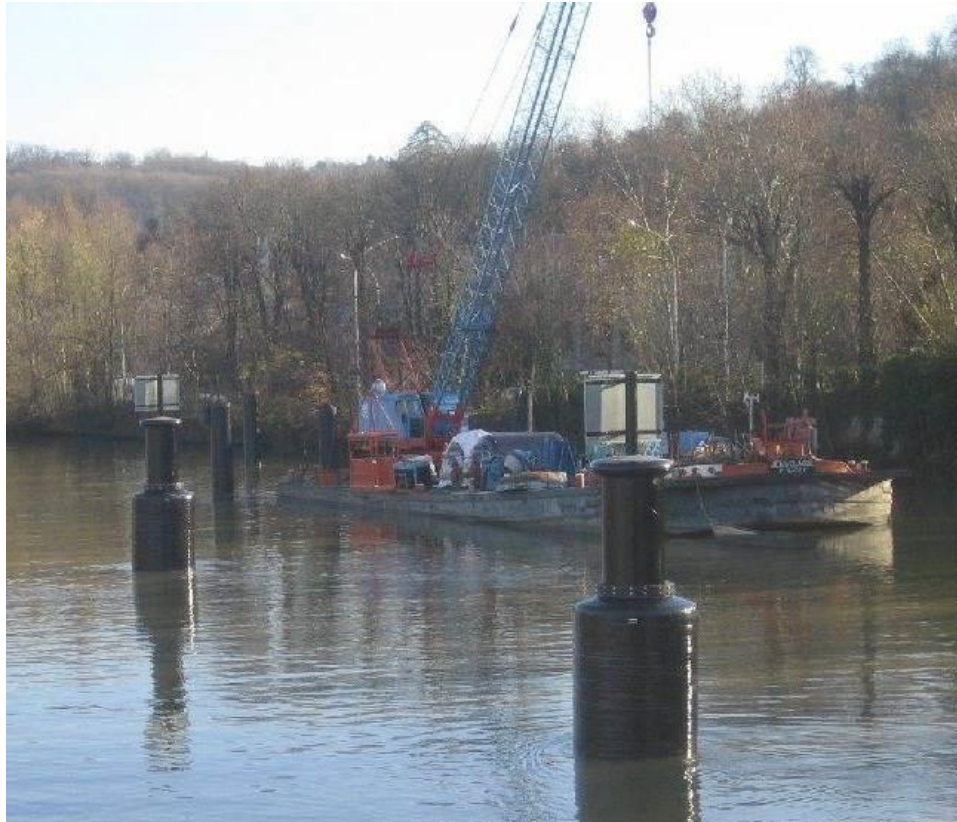
Figure 18: Exemple de Ducs d'Albe d'accostage avec des défenses rotatives (donuts). Source : VEOS group | Défenses annulaires
