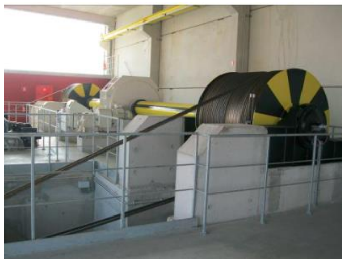
Figure 32: Exemple d'un système de manœuvre de porte roulante à câbles
