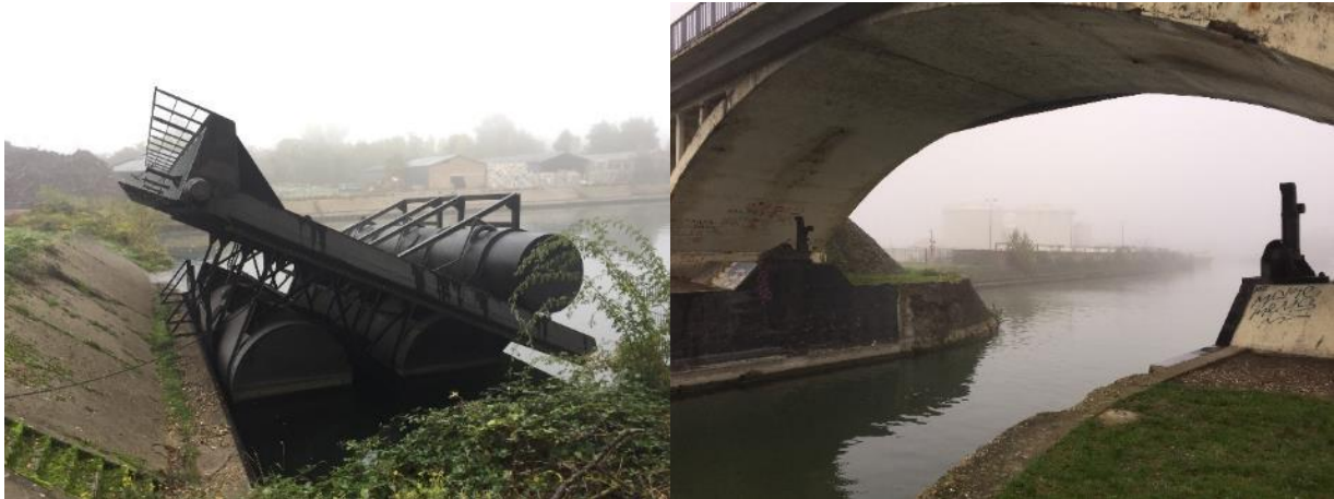
Figure 2: A gauche: porte flottante en position de stockage / A droite: passe navigable et pièce métallique fixe en U
