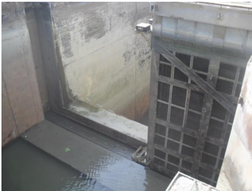
Figure 6: Exemple d'une porte latérale sur une écluse de 12 m de large sur le Rhône
